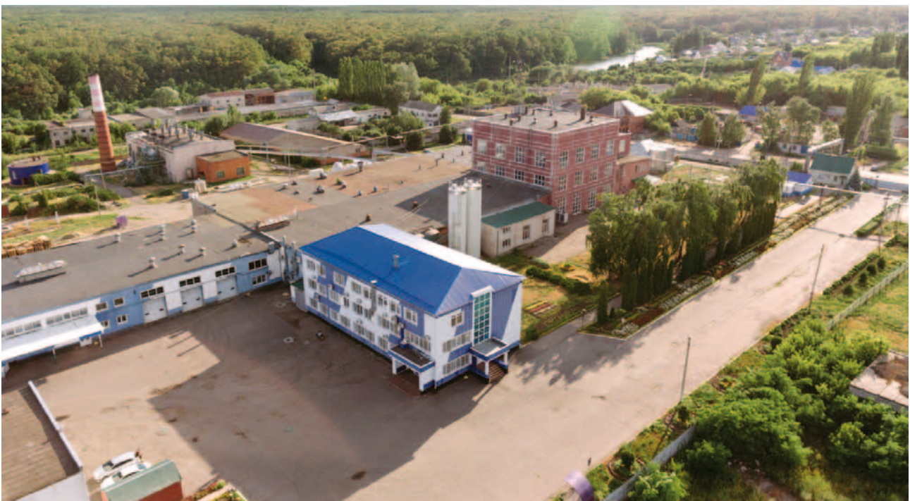
Nach erfolgreicher Modernisierung wird die Molkerei „Anna“ in der Region Woronesch eine Verarbeitungskapazität von ca. 300 Tonnen Rohmilch täglich haben.
