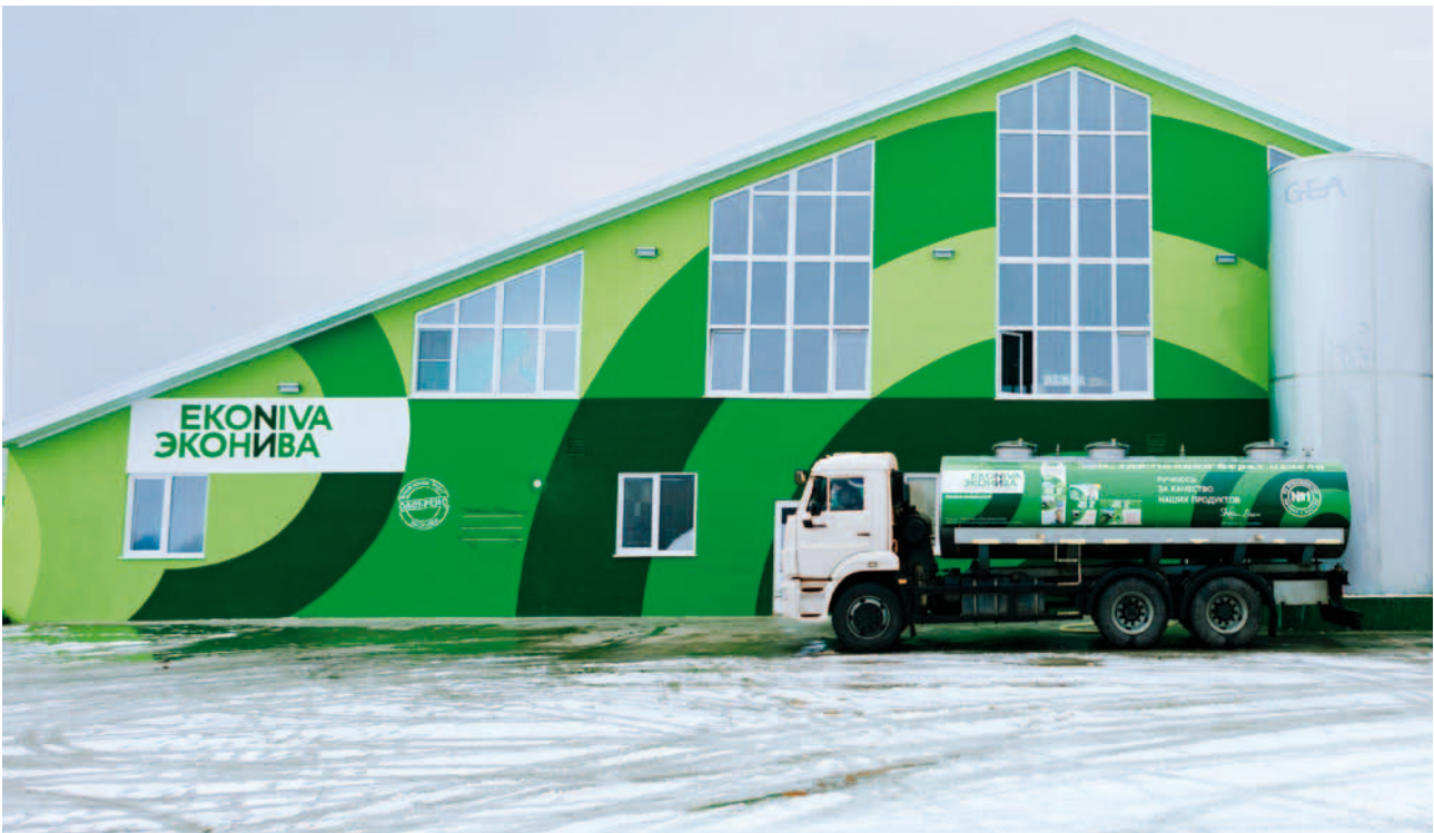
Neue Milchviehanlage in der Region Kaluga - In 2019 hat die Unternehmensgruppe insgesamt sieben moderne Milchviehanlagen fertiggestellt.
